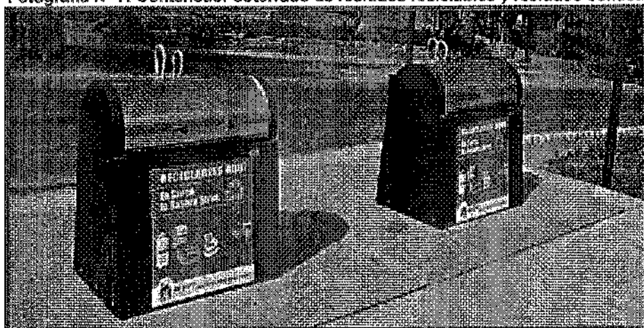
Fotografía N° 7. Contenedor soterrado de residuos reciclables y residuos sólidos
