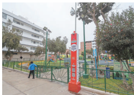
30 postes de Atención Rápida para emergencias o peligros
