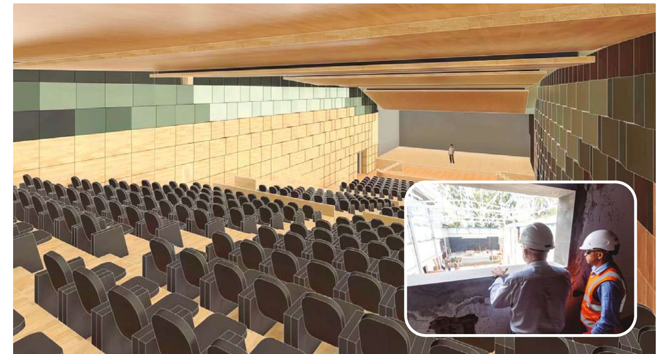
Falta poco. A buen ritmo se están llevando a cabo las obras de remodelación del teatro de Surco, uno de los sueños de Carlos Bruce.
