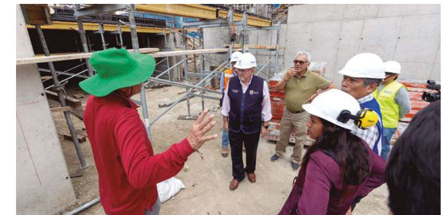
Inspeccionando. El alcalde visitó las obras del amplio estacionamiento que tendrá el teatro.
