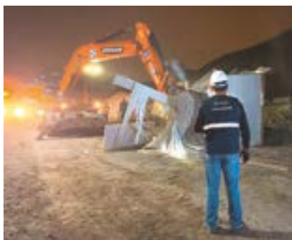
Cerro Centinela. Se demolieron construcciones no autorizadas para conservar el entorno natural.
