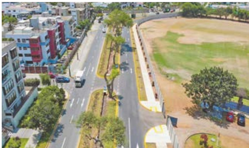
Av. Lima Polo. Intervenciones optimizan la transitabilidad y fortalece la conexión con otros distritos de Lima Metropolitana.
