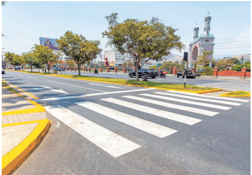
Avenida Caminos del Inca. Mantenimiento vial en marcha.
