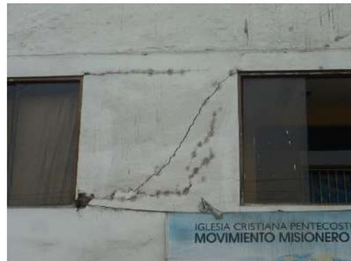
Figura 36. Vivienda de tres niveles donde con agrietamiento diagonal
