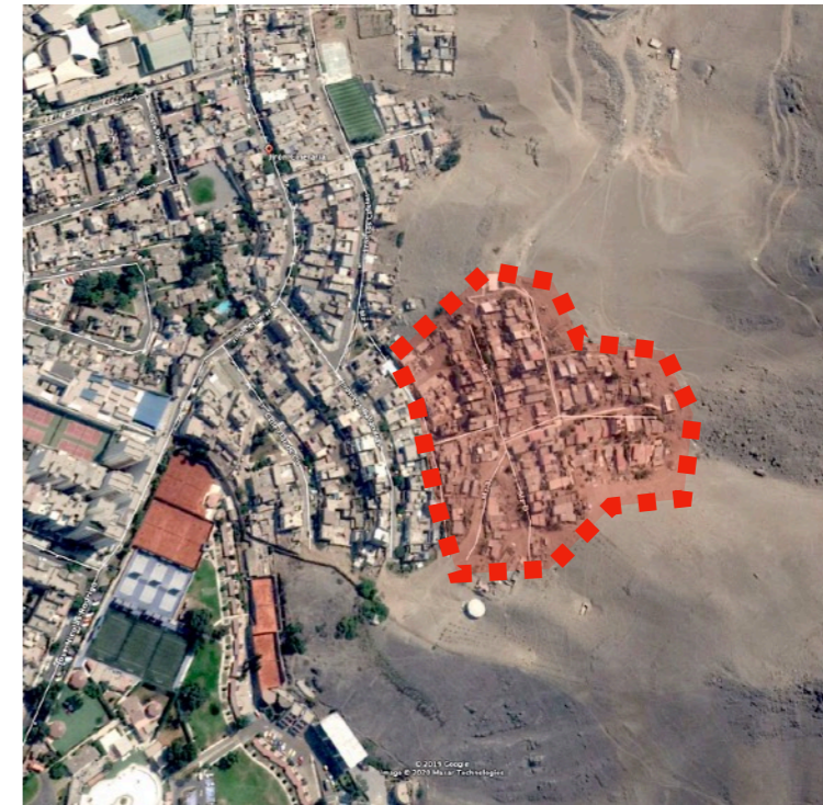
SECTOR 8: Asentamiento Humano Diente de Oro Ubicado en zona de alto riesgo por peligro de deslizamiento: ladera de cerro con alta pendiente y suelo arenoso
